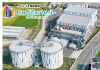
バイオガスプラント
