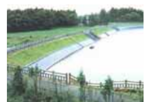
改修された老朽ため池
