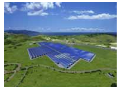
太陽光発電施設
