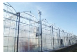
生産技術高度化施設 (低コスト耐候性ハウス)
