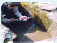
水路のひび割れ補修
