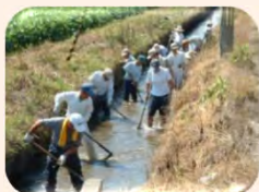
水路の泥上げ
