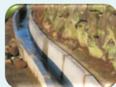
コンクリート水路の更新
