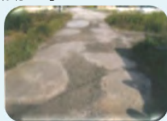
農道の窪みの補修
