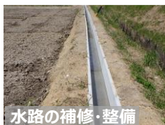
水路の補修・整備
