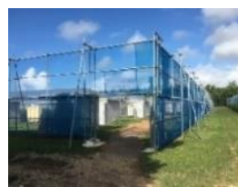
防風ネットの設置
