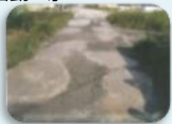
農道の窪みの補修
