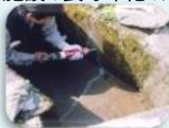
水路のひび割れ補修
