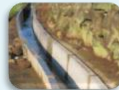
コンクリート水路の更新
