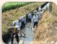
水路の泥上げ
