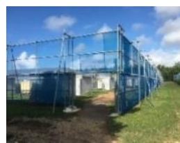
防風ネットの設置
