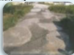
農道の窪みの補修
