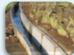
コンクリート水路の更新
