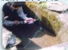
水路のひび割れ補修
