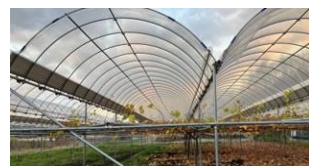
簡易雨よけ設備の設置
