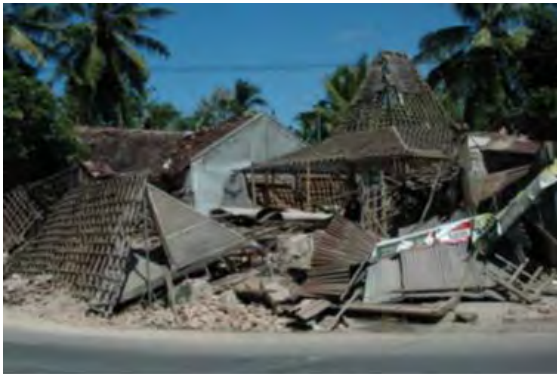
RC 柱レンガ組住宅の倒壊状況
