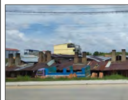
レンガ焼き小屋の外観
