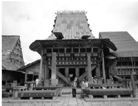
図 IV-5 インドネシア・ニース島の伝統的木造建築（花里 2014）
