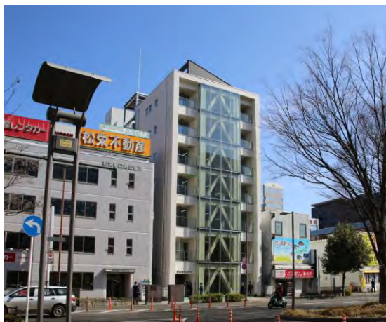
写真 3 高惣木エビル（木造 7 階建て 仙台駅前）
