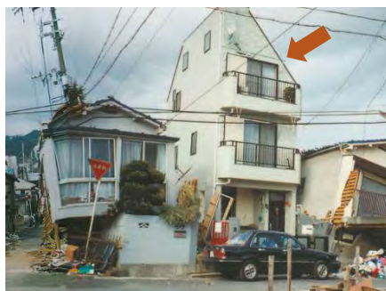
写真 5 阪神大震災で倒壊しなかった KES 構法による三階建木造住宅 ((株)シェルターHP)
