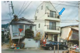
KES構法で建てられた木 造住宅が、1995年の阪 神・淡路大震災に耐えた 事例
