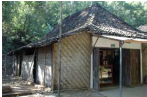
倒壊しなかった木柱と竹網壁の住宅
