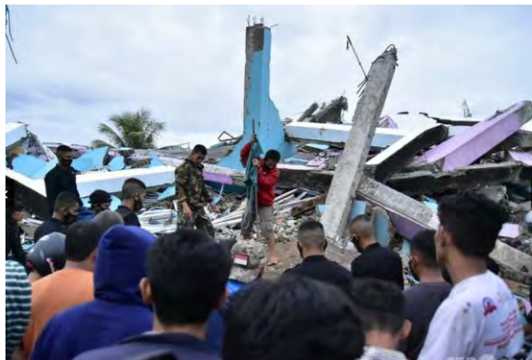
写真 2 2021 年スラウェシ島で発生した地震で倒壊した病院 （スラウェシ島マムジュ AFP ニュース）
