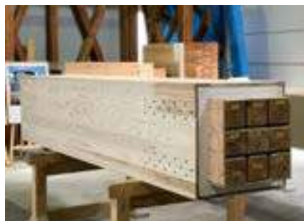
写真 7 COOL WOOD の芯材部に用いられたスギ製材の「束ね柱」 (令和 2 年 森林・林業白書)
