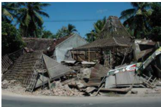
RC 柱レンガ組住宅の倒壊状況
