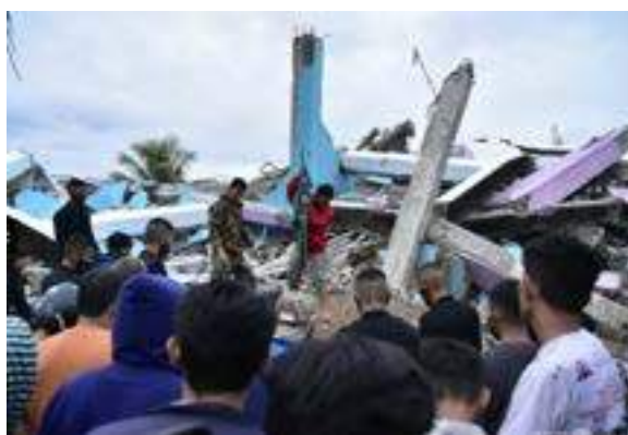
写真 2 2021 年スラウェシ島で発生した地震で倒壊した病院 （スラウェシ島マムジュ AFP ニュース）
