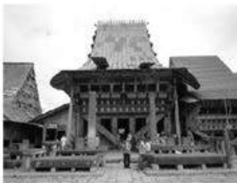
図 IV-5 インドネシア・ニアス島の伝統的木造建築（花里 2014）
