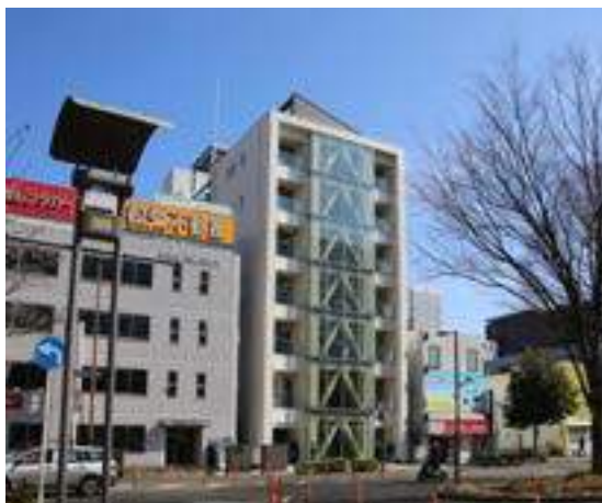
写真 3 高惣木エビル（木造 7 階建て 仙台駅前）
