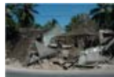
RC柱レンガ組住宅の倒壊状況
