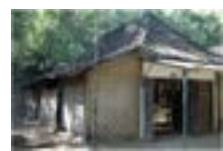
木柱と竹網壁のくし合わせによる住宅(外側のレンガ組壁は倒壊)
