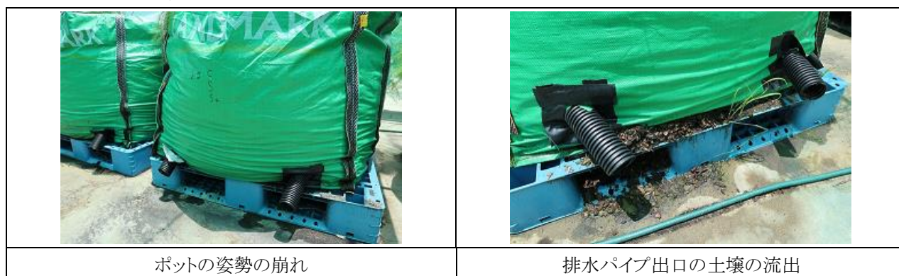
図表 30 ポットの姿勢の悪化と排水パイプの処理
