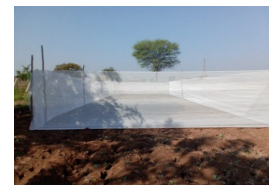
外虫忌避ネットの設置
