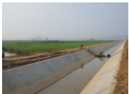
改修された水路
