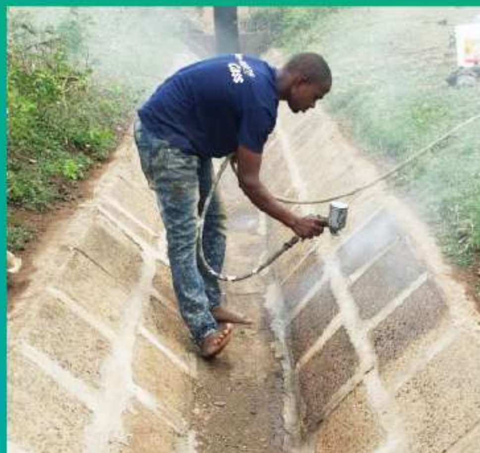
Démonstration de mesures visant à augmenter les superficies rizicoles, y compris la prévention des fuites des canaux d'irrigation
