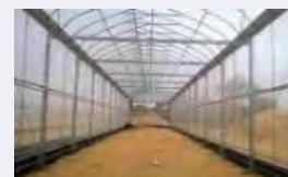
グリーンハウスの施工例 (写真提供: すべてWatanabe Pipe Vietnam)
