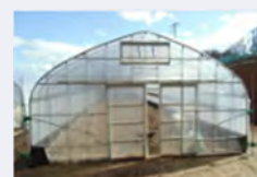
グリーンハウス外観
