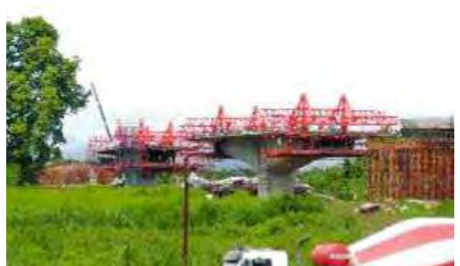
建設途中の第二友好橋
