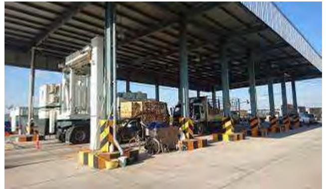
新設された X 線検査場
