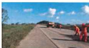
Serviços de conservação na BR-163/PA Fonte: DNIT/UL - Itaituba Junho de 2016
