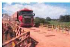
Reconstrução da ponte de madeira sobre o Rio Itamarati BR-158/PA Fonte: DNIT/UL – Marabá Junho de 2016
