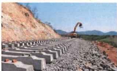
Obras: Ilhéus/BA – Barreiras/BA
