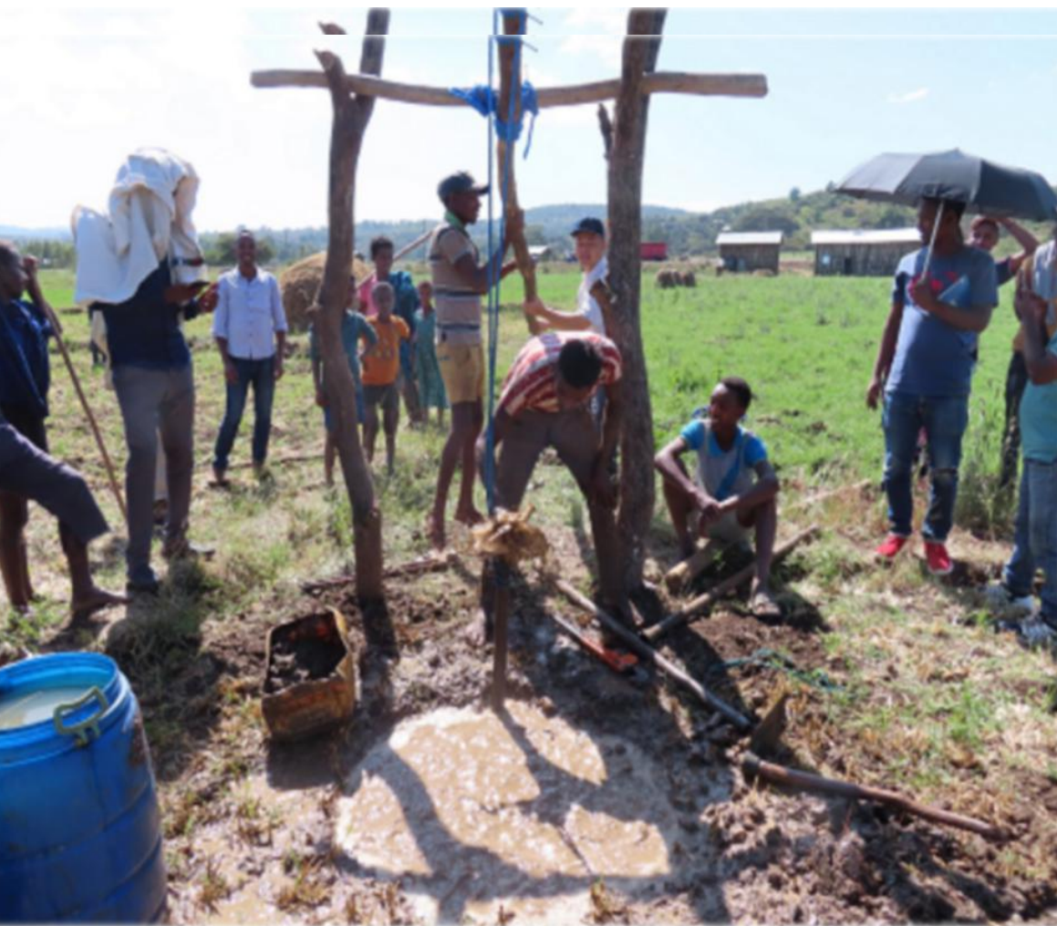
人力での井戸掘り
