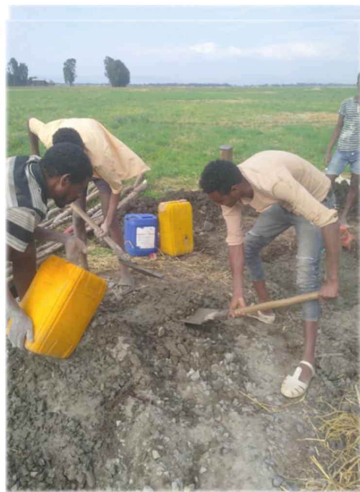
コンクリート練り
