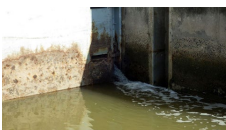
既存水門から流入する塩水
