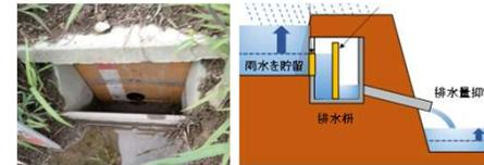
落水口に流出量を抑制する樹等を設置し、湛水被害リスクを低減
