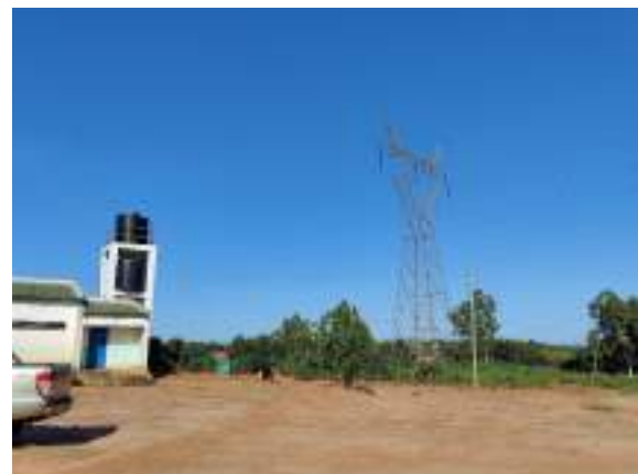
図 56 貯水・電気設備
