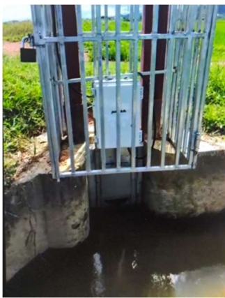
図 4 : 取水側自動ゲート、排水側自動ゲート、水位センサーの各設置状況
