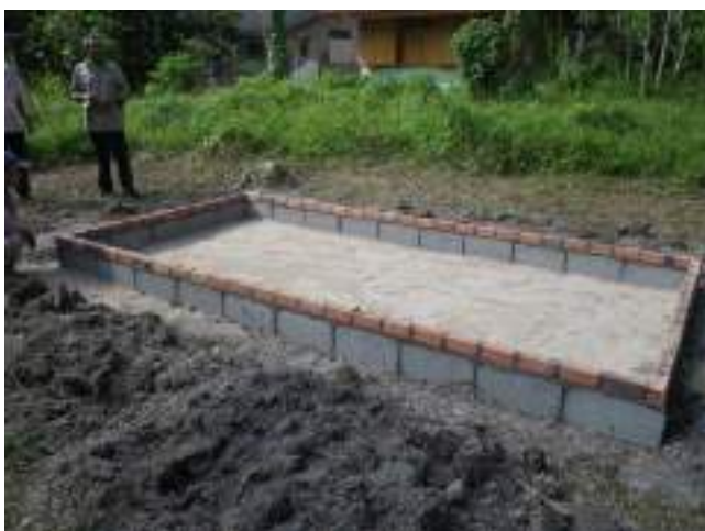
湛水馴化処理用のプール（コンクリートブロック・レンガ製、防水シートで覆う前、タイ、ナコンシタマラート県チャウワット）
