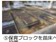
⑤保育ブロックを苗床へ設置
