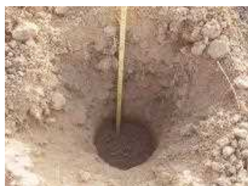
①オーガーを用い、直径 20 cm、深さ 50 cm の植穴を掘った。
