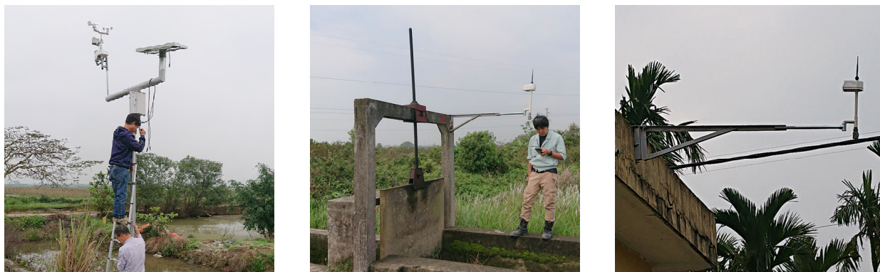
写-1 アンホア・コミューンにおける ICT 機材の設置
