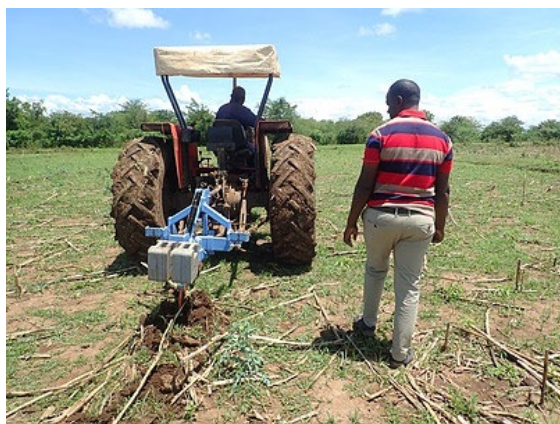
カットドレーンミニ施工状況
