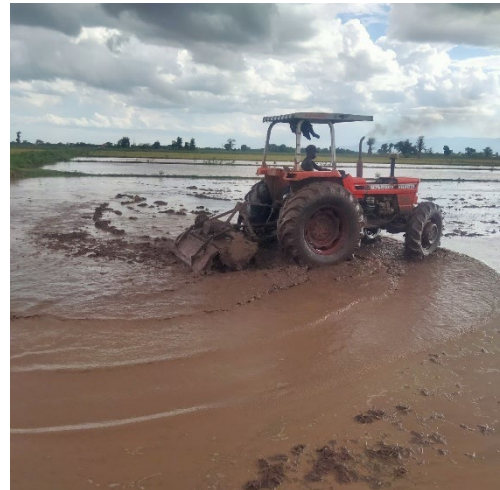
ほ場漏水対策（代掻き）
