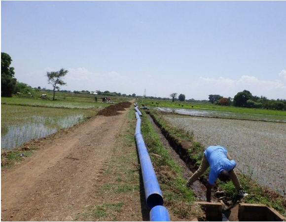
土水路漏水対策（パイプ敷設状況）
