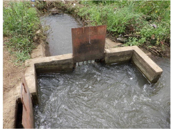
土水路漏水対策（スクリーン設置）
