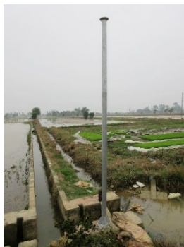
写真 6 カメラを取り付ける鋼管支柱の設置状況
