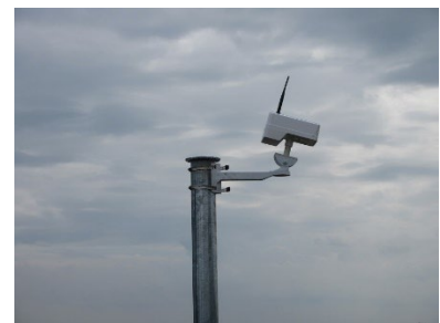
写真 3 カメラの取付け状況
