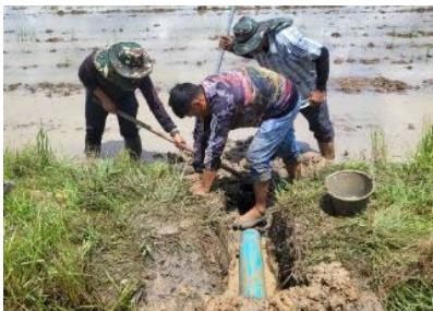
農地への暗渠排水の設置
