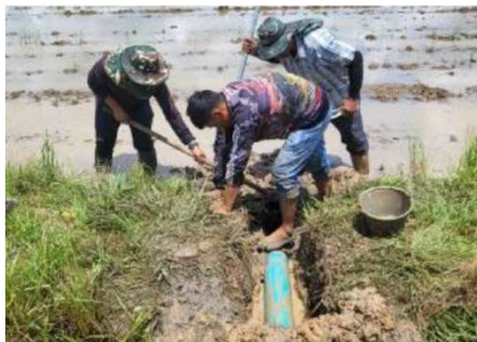
農地への暗渠排水の設置
