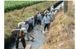
水路の泥上げ
