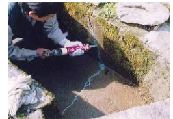
水路のひび割れ補修
