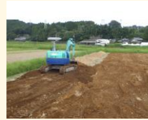
土層改良（客土）
