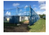
防風ネットの設置
