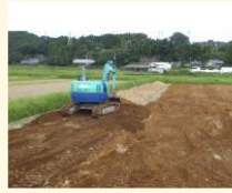
土層改良（客土）
