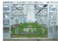
高い純度や無病性が 確保できる隔離施設
