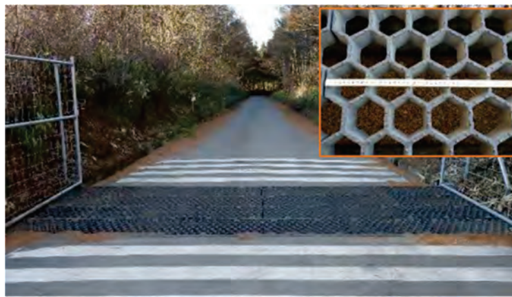
写真-2.2.2 侵入防止用グレーチング 10)
