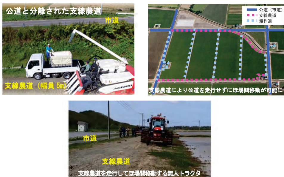
図-3.4.11 農業機械の接触事故防止を考慮した支線農道の整備事例 6)
