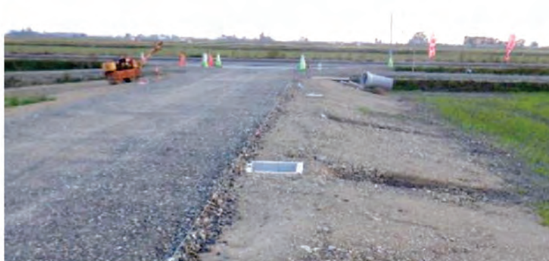
写真-4.4.1 埋設した給水栓 7)
