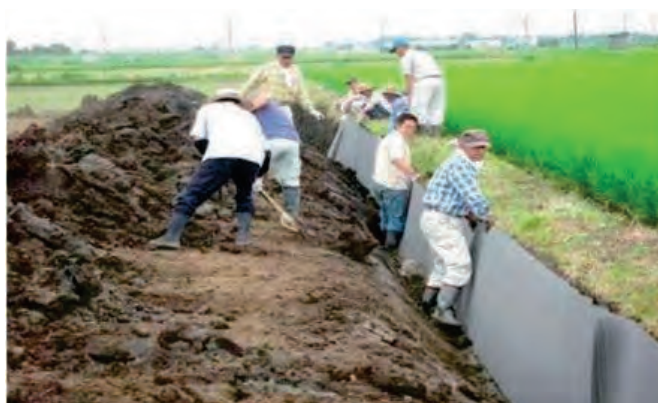
農業者等による直営施工
