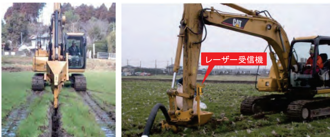
写真-5.3.2 非開削式暗渠工法（アーム式ベストドレーン工法）の作業状況
