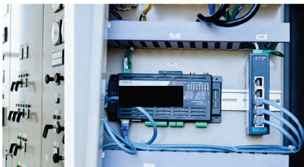
写真-4. 10. 3 揚水ポンプ自動制御システム (既存手動システムに後付けで遠隔操作機能を追加)
