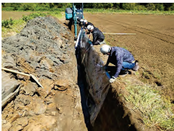
ほ場整備事業における施工
