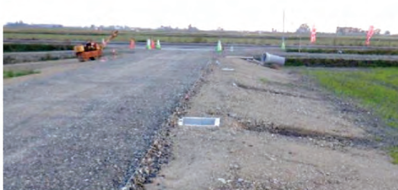
写真-3.4.1 埋設した給水栓 7)
