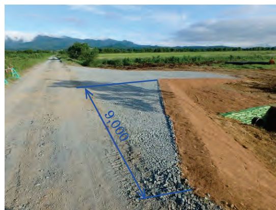
図-4.3.21 進入路の隅切り部分を拡幅した事例 7)
