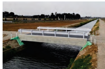
写真-4.4.2 水路横断工として門形カルバートを用いた事例
