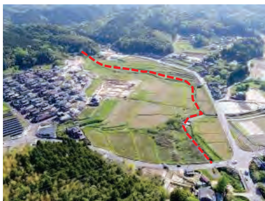
整備前 (赤線に大きな傾斜あり)
