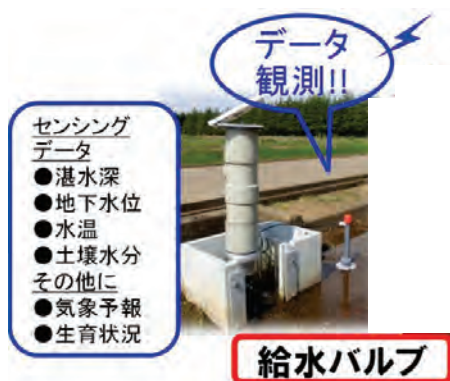
図-3.6.9 多機能型自動給水栓の例 7)
