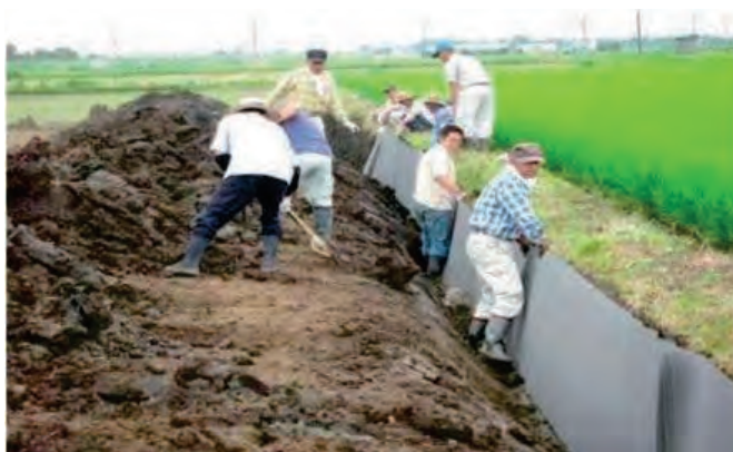
農業者等による直営施工
