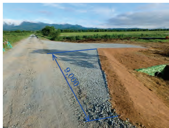
図-3.3.23 進入路の隅切り部分を拡幅した事例 7)
