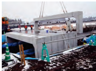
写真-4.4.2 水路横断工として門形カルバートを用いた事例
