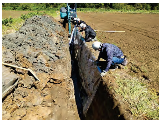
ほ場整備事業における施工
