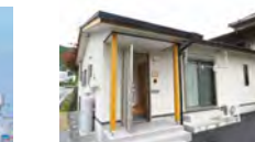
空き家の改修(お試し居住施設)
