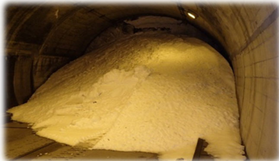
【写真】大滝地区トンネル
