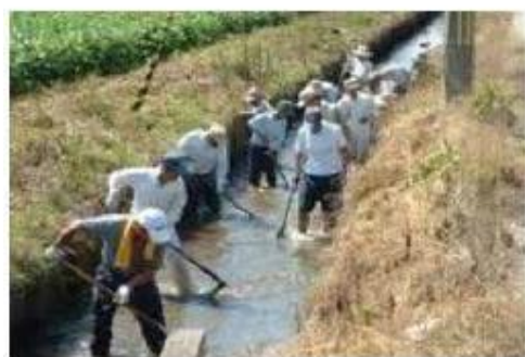
水路の土砂さらい
