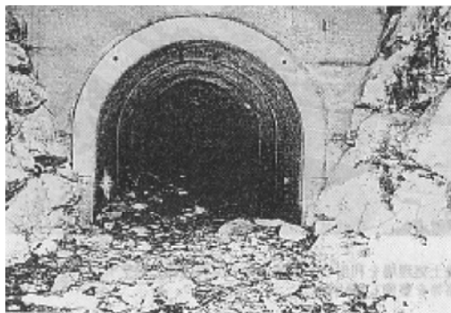
図-10.2.21 動物の移動経路を確保した横断工の例
