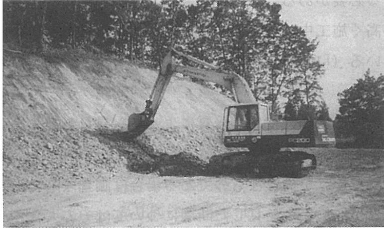
図-13.2.8 切土法面の仕上げの状況
