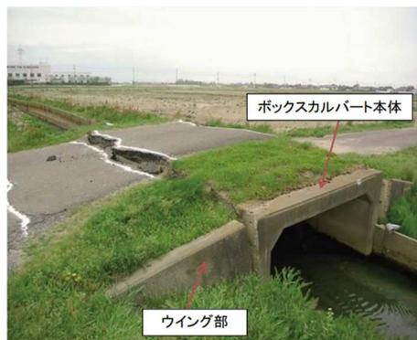
図-10.2.9 地震によりカルバート区間で発生した段差<sup>24)</sup>
