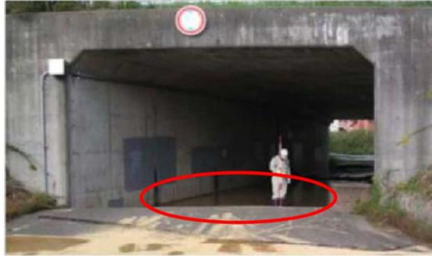
図-10.2.6 カルバートの沈下による帯水<sup>22)</sup>
