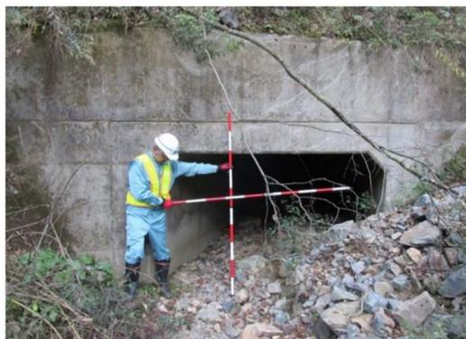
図-10.2.8 土石流入による水路カルバートの通水阻害<sup>23)</sup>
