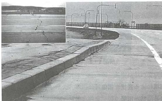
図-10.2.12 凍上によるボックスカルバート上の舗装の押し上げと亀裂<sup>10)</sup>
