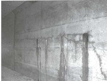
図-10.2.11 凍上によりボックスカルバート側壁に発生したクラック<sup>10)</sup>
