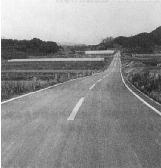
歴史的風土保存地区、風致地区に指定されていることから、景観を線的に分断するガードレールに代えて、目立たない構造のガードケーブルを用いている。
