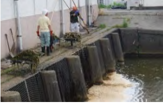
スクリーンの除塵作業
