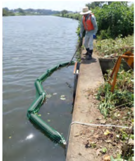
取水口の機能阻害予防のための ダストフェンスの設置
