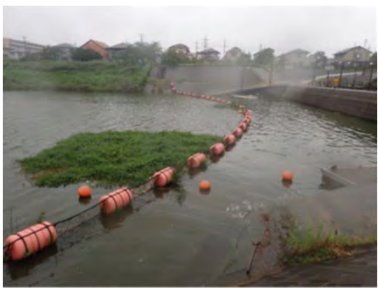
排水機場への被害予防のための 防護ネットの設置
