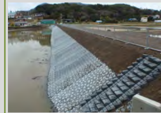
ため池護岸の整備
