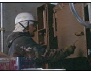
(ゲートの塗装)
