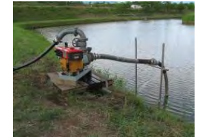
応急ポンプの設置・運転
