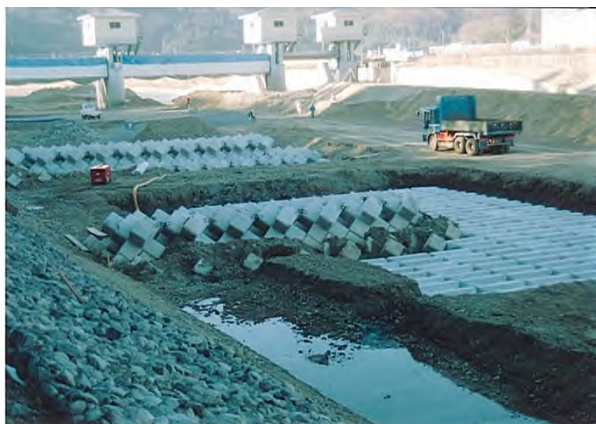
写真-9.6-6 上流側から見た現地状況（水制工施工中）
