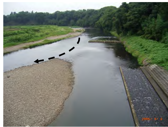
写真-9.6-7 上流側から見た現地状況 （水制工完成後の状況）
