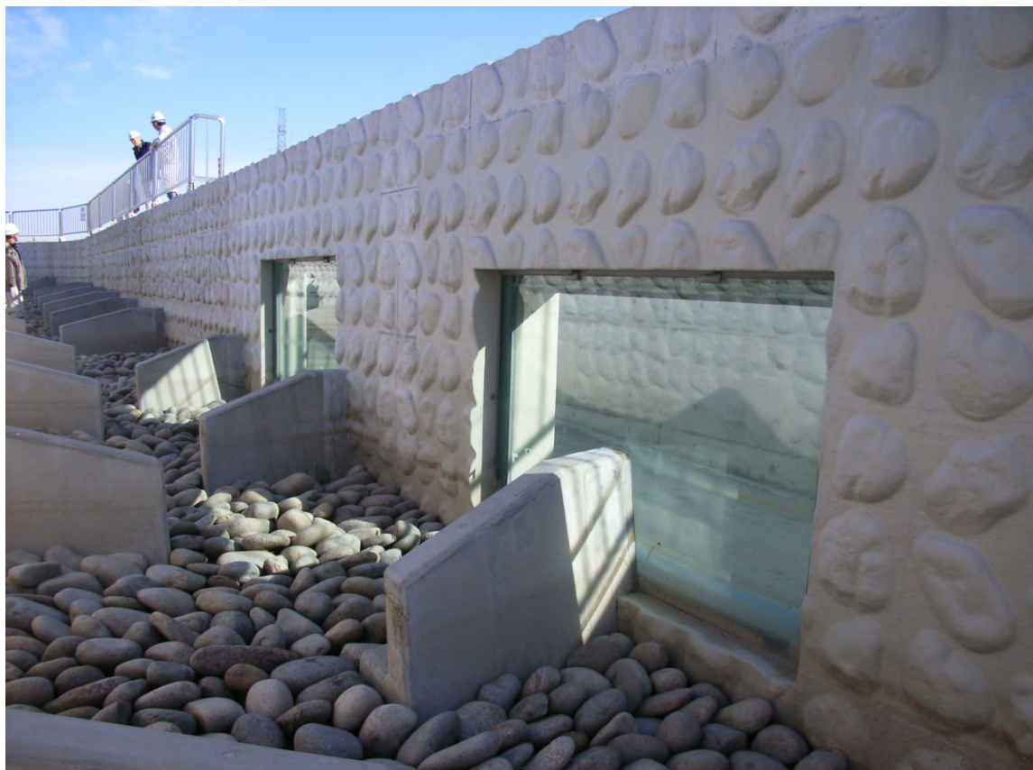
写真-19.13-3 魚道モニタリング施設
