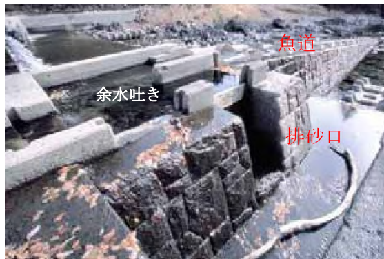
図-19.10-3 排砂口を設けた事例（岐阜県根尾川 長島頭首工）
