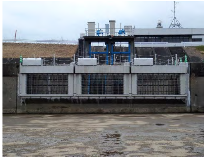
写真-24.4-3 回転体型スクリーン採用事例（岡島頭首工）
