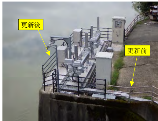
写真-24.4-4 整備前後の安全設備（栗生頭首工）
