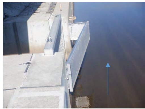
写真-24.4-1 固定式遮蔽板（大戸川頭首工）
