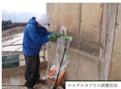
写真-27.10-1 鉄筋挿入工法施工状況
