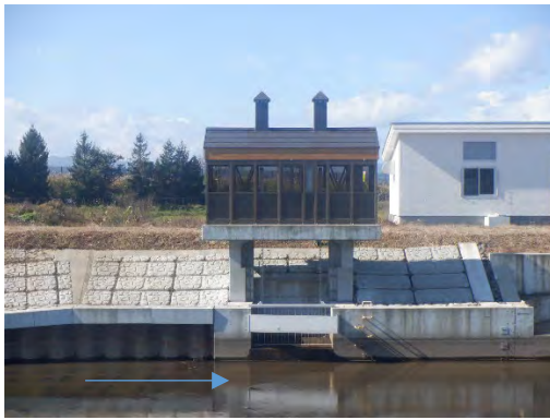
写真-24.4-1 固定式遮蔽板（大戸川頭首工）
