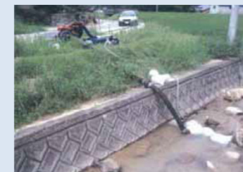
仮設ポンプを設置し、用水を確保
