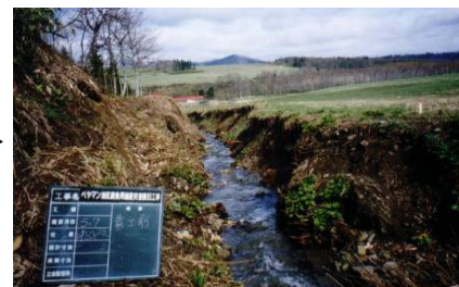
土水路をU字フリュームで復旧
