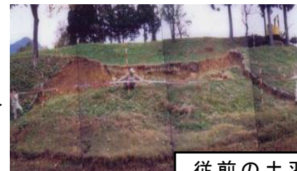
従前の土羽による畦畔の復旧
