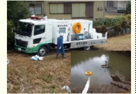
排水用ポンプ車の派遣
