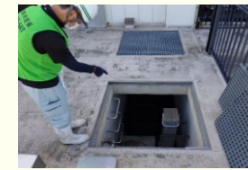
農業集落排水施設の点検
