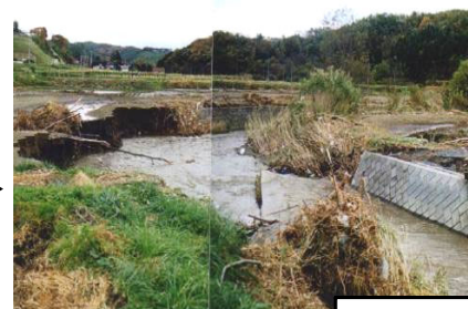
木橋をPC橋で復旧
