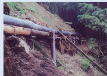
仮設水路を設置し、用水を確保
