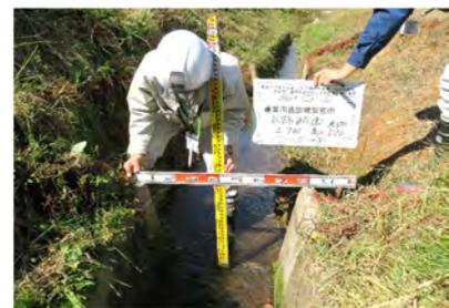
図3-5 水路断面の計測状況(2名で対応可能)
