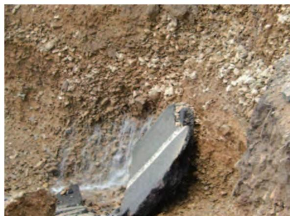
図4-21 崩壊面からの湧水発生状況の例
