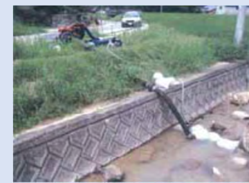
仮設ポンプを設置し、用水を確保
