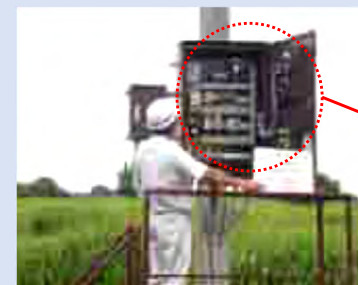
浸水した揚水機場の制御盤の部品を交換することによりポンプ機能を回復
