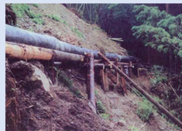
仮設水路を設置し、用水を確保
