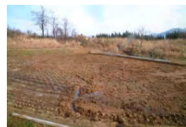
査定前着工により復旧した農地
