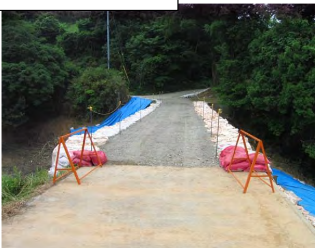
堤体仮補修状況
