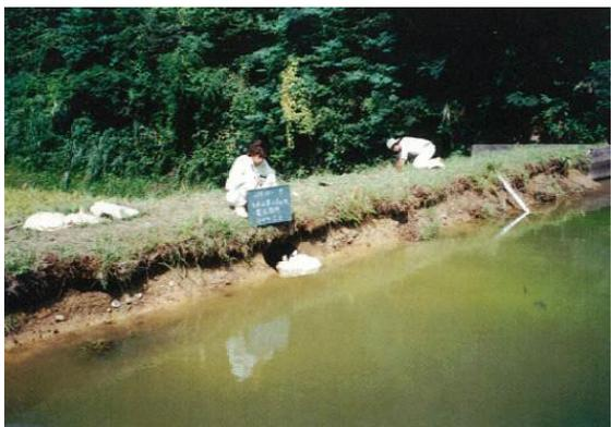
(急激な水位上昇により法面が洗掘され、また、堤体の一部が陥孔作用を起こし空洞が発生)
