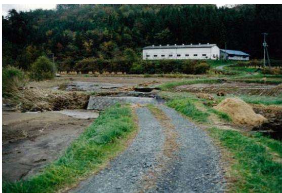
(豪雨により河川が増水し橋台が流出したため橋桁が崩壊)
