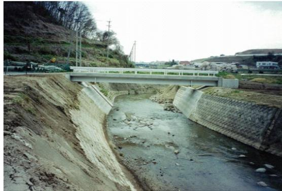
(永久構造のH桁鋼橋(単純非合成桁橋)により復旧)
