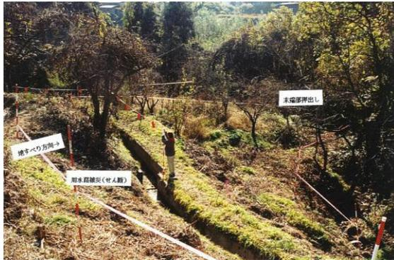
(地すべりにより用水路が押されてせん断し、上部の農地には滑落段差やクラックが生じる等の被害)
