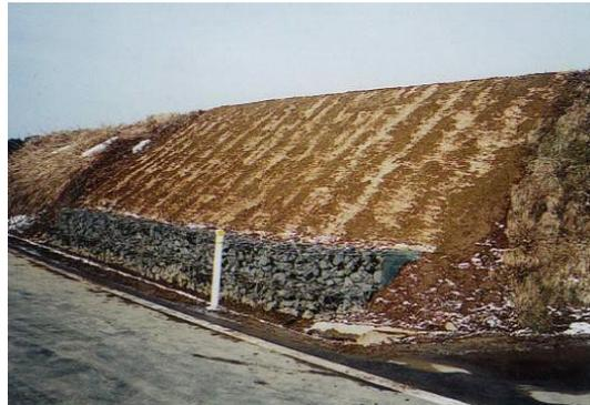
(崩壊土砂の撤去と被災箇所の法面下部にフトン管 2 段積+盛土を実施)
