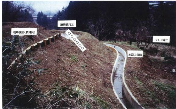
(鋼管杭打、横孔ボーリング、フトン管等の農地保全施設を新設、水路及び畦畔(農地災)を復旧)
