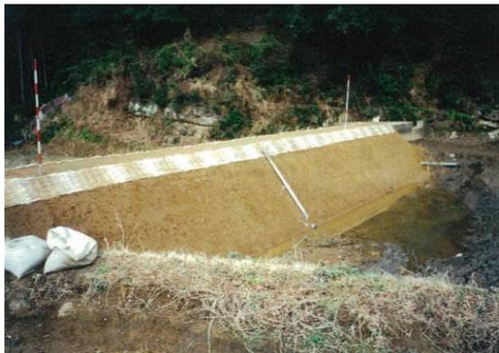
(貯水機能の確保、又堤体の安定を図るため、空洞部を取り除き、前刃金工により復旧)
