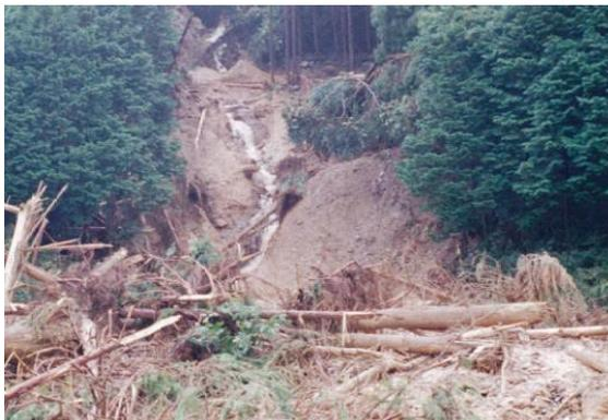
(上流からの洪水による著しい侵食による水路の流失及び土石流による農地の埋没)
