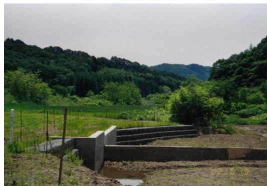
(コンクリート擁壁工及び取付護岸カゴマット工法で復旧)
