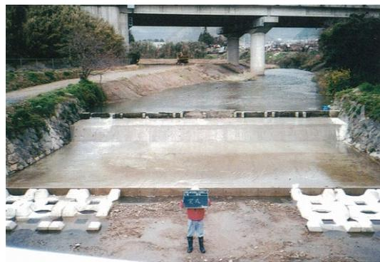
(護床工を消波根固めブロックで復旧)
