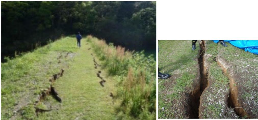
写真 2-8-4 堤体のき裂被害（熊本地震(H28.4)）
