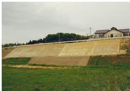
(法面を段切りして盛土、法面整形後、植生工をして復旧)
