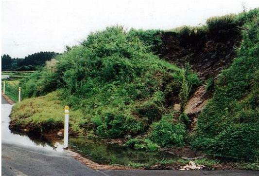
(豪雨により道路法面が崩壊、土砂が車道まで流出し車両の通行に支障)
