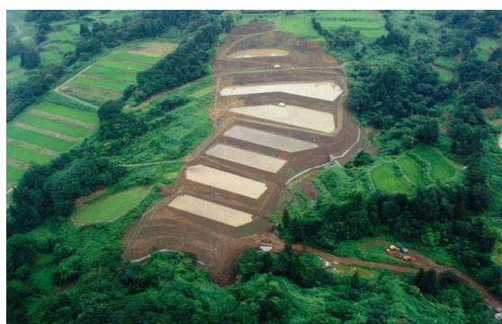
(著しい地形が変化し原形復旧が不可能となったため、区画を変更して復旧。農地保全施設として押え盛土工、地下水排除工を設置)
