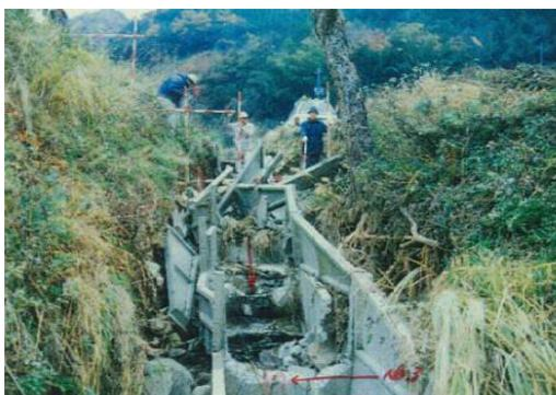
(豪雨により、土砂と同時に水路が流出し崩壊)
