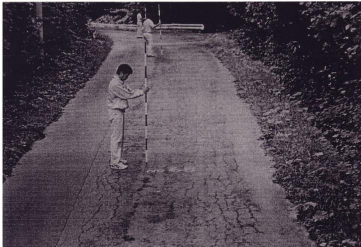
写真 2-11-1 凍上による被災状況
