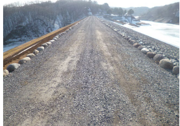
2) 復旧状況写真
