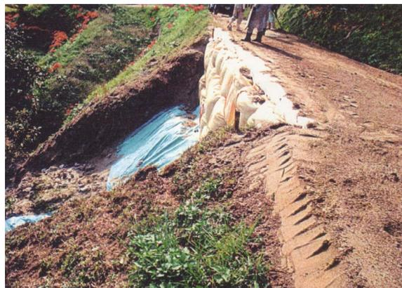
(大型土のうにより復旧までの増破及び通行確保を図る)
