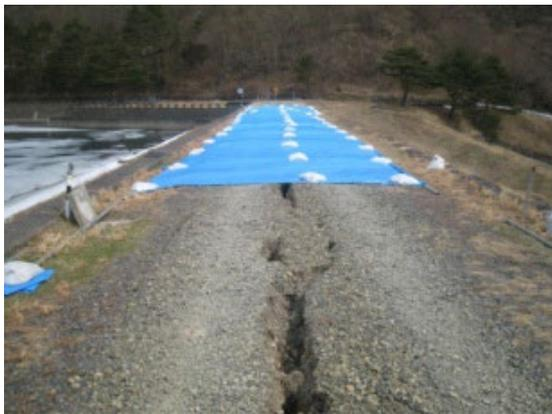
写真 12-2-1 ため池の地震直後の被災写真
