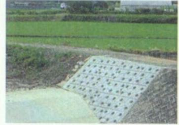
隣接する河川護岸が環境保全型ブロックで施工されており、生物の棲息可能な空洞がある環境保全型ブロックで復旧。(中四国)
