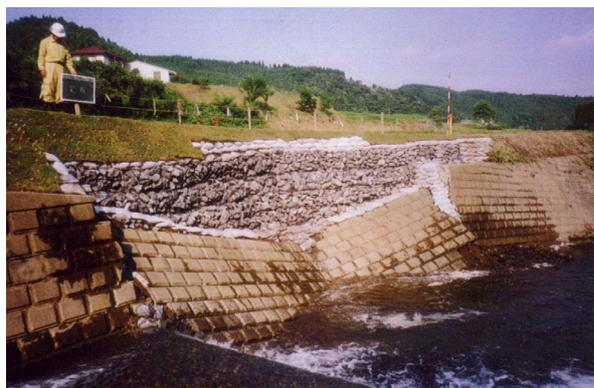
(増破防止のため蛇籠により安全の確保を図る)
