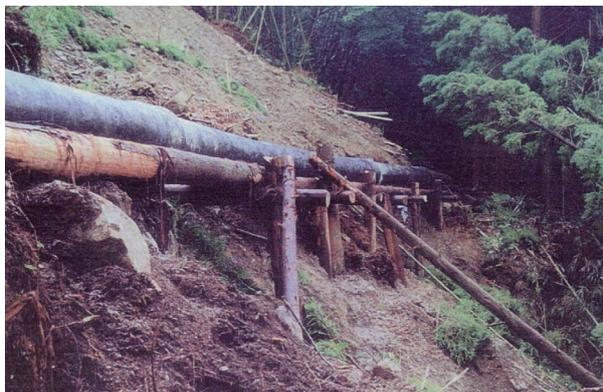
(仮設水路により用水の確保を図る)
